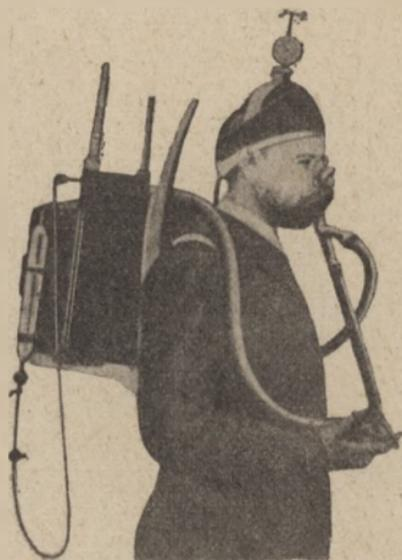
FIG. 280. — Appareil respiratoire portable de Zuntz.
