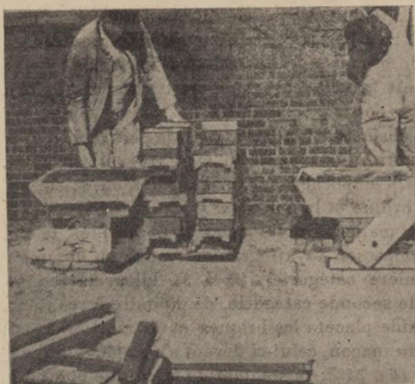
FIG. 315. — Briques et mortier à portée de la main du maçon.
