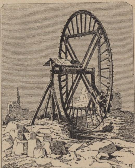
FIG. 222. — Roue à chevilles ou treuil des carriers.
