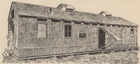
Fig. 195. Transportable Baracke (System Döcker).
